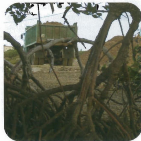
Déboisement et remblais
